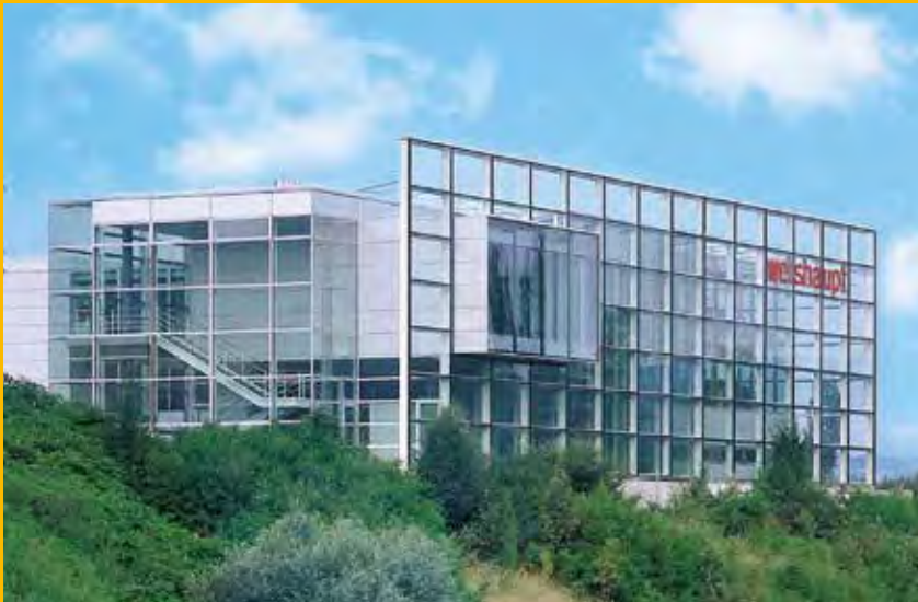
Schulungs- und Verwaltungsgebäude in Geroldswil (ZH)
