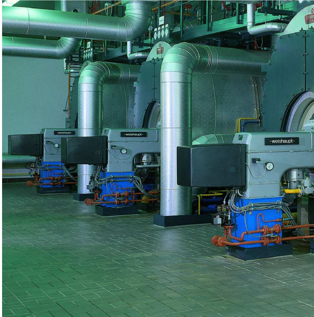
Fernheizwerk mit Weishaupt-Zweistoffbrennern WKGL50 und WKGL3 – Gesamtleistung 28 MW
